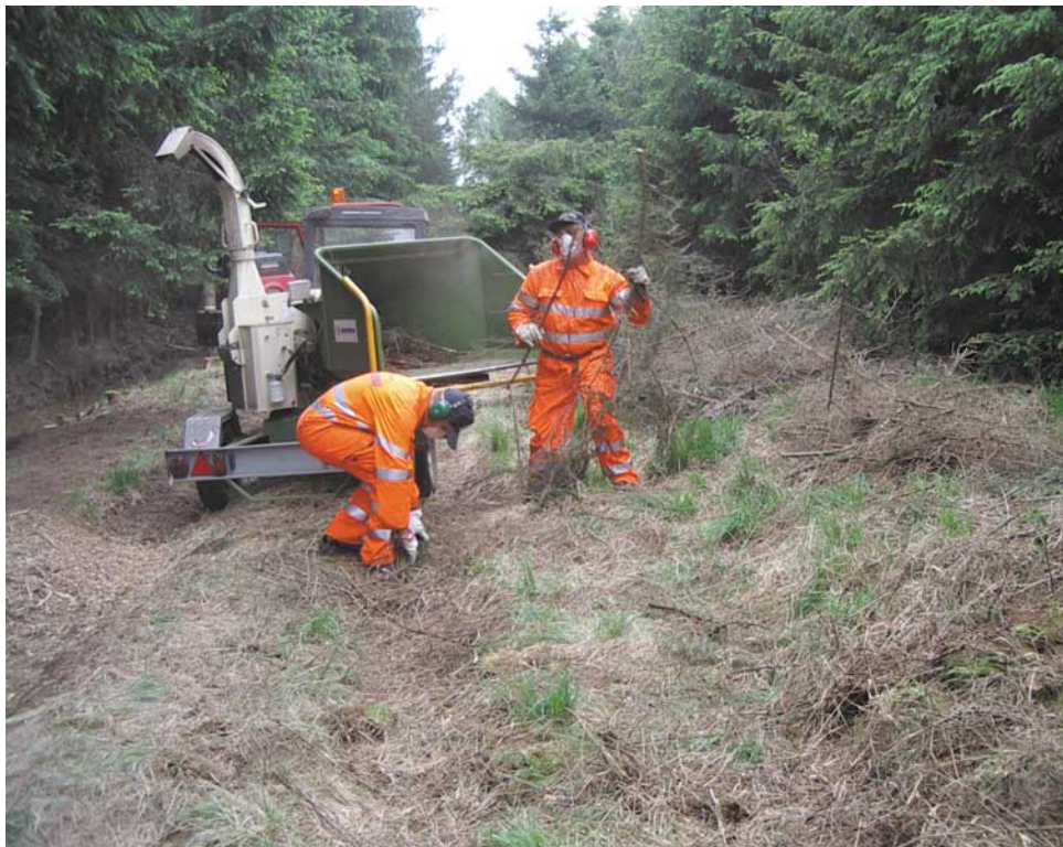
Alpini al lavoro di sgombero delle sterpaglie dal canale.
